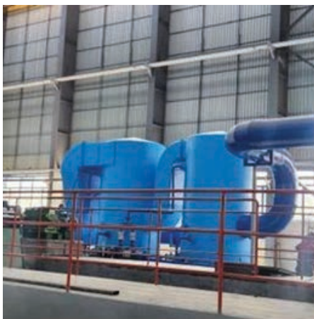
Slika 7.5. Primer industrijskog skrubera (levo) i šematski prikaz načina rada (desno)
