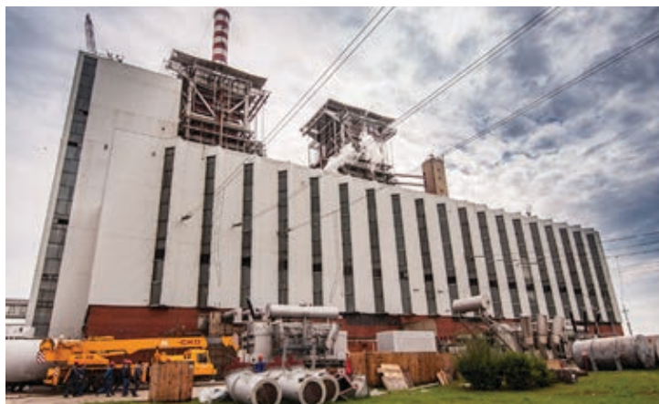
Slika 7.3. Elektrostatički filteri na termoelektrani Kostolac
