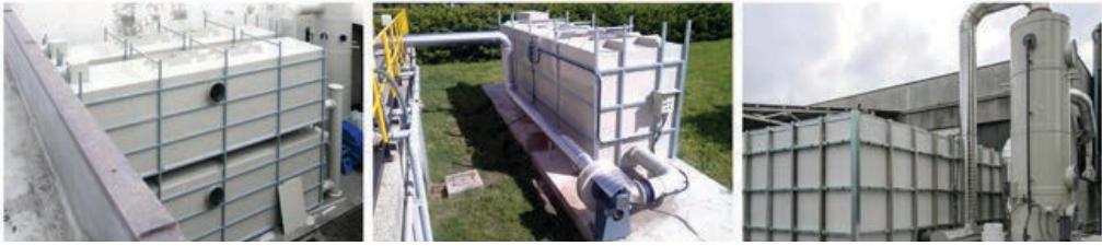
Slika 7.6. Primer industrijskog postrojenja za biološki tretman zagađenog vazduha
