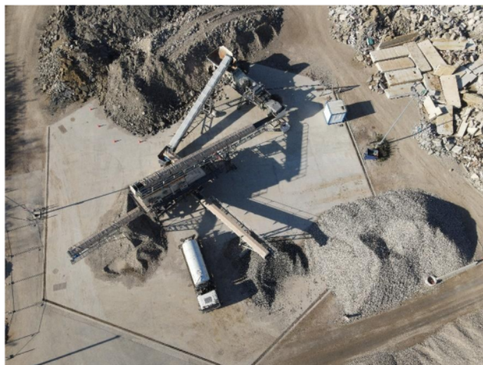
Слика 17: Поглед на постројење одозго, 2023 [37]
