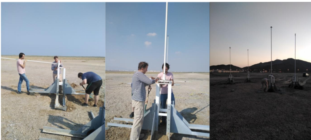
Slika 4.19 Postavljanje Tx antenskog niza na poligonu
