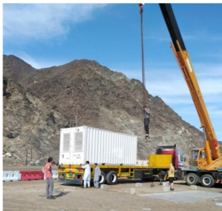
Slika 4.18 Prevoz i instalacija Tx kontejnera bistatičkog radara
