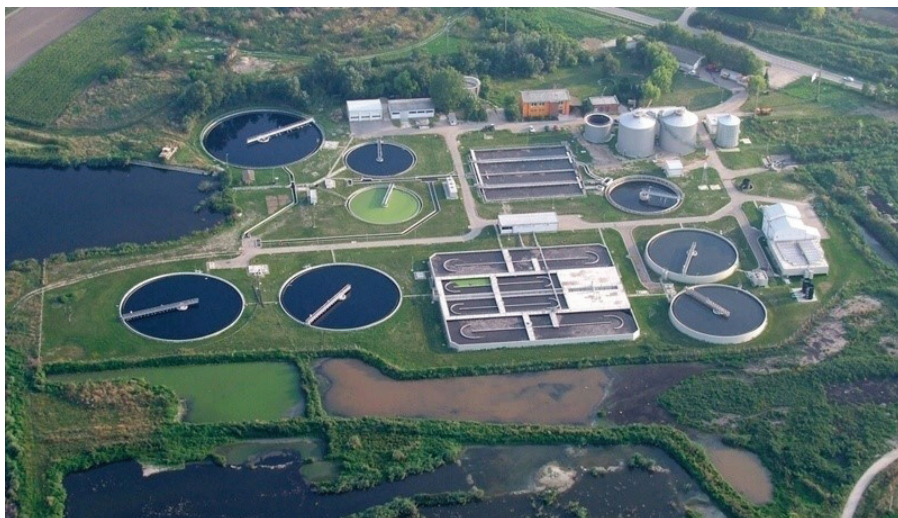
Слика 73. Постројења за пречишћавање отпадних вода
