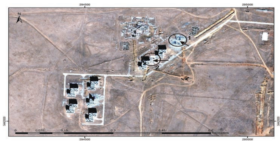
Slika 17.11: Grad Mardai u blizini otvorenog kopa Dornod, prikazane su pozicije uništenih stambenih objekata gde je izvađena gvozdена armatura kao sekundarna sirovina (raster osnova SASPlanet ArcMap Imagery)
