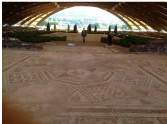
Slika 73. Zaštitna konstrukcija u izgradnji na arheološkom nalazištu Mediana, Niš
