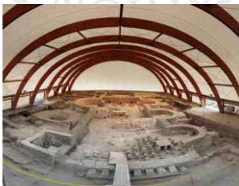
Slika 22. Viminacium – autentično rimsko kupatilo iz II-IV veka u kreiranom prostoru zaštitne konstrukcije sa svodom
