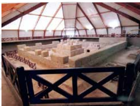
Slika 21. Viminacium - autentični mauzolej iz sredine III veka u kreiranom prostoru piramidalne zaštitne konstrukcije
