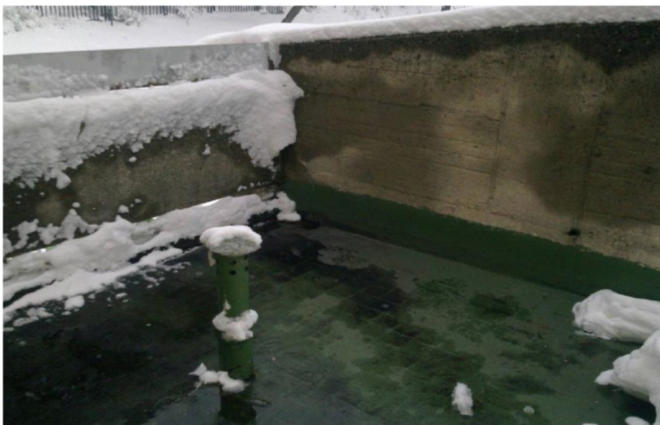
Слика 11.2. Фотографија сегмента кровне терасе
