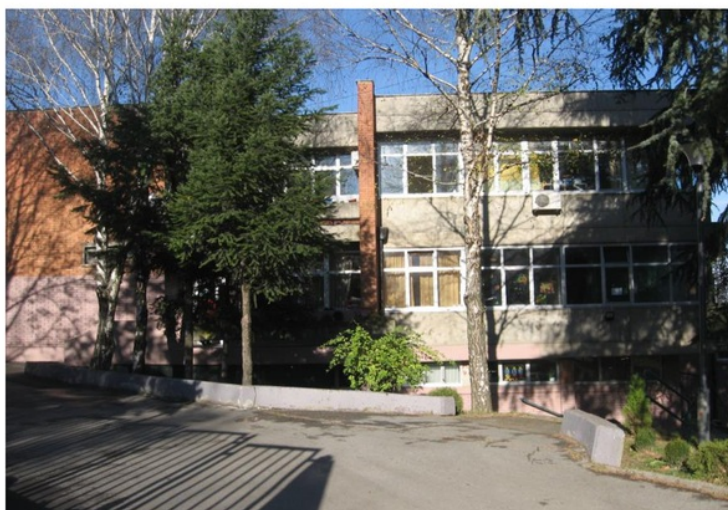
Слика 17. Фотографија објекта који је предмет истраживања
