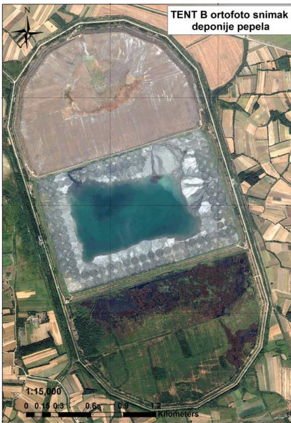
Slika 16. Ortofoto snimak deponije pepela na lokaciji TENT „B“
