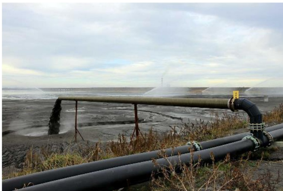
Slika 14. Novi sistem odvođenja pepela iz TENT „B“ na aktivnu kasetu
