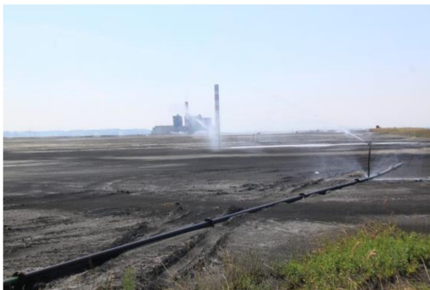
Slika 12. Raspored prskalica na obodu deponije pepela TENT „A“ koje sprečavaju podizanje pepela u vazduh
