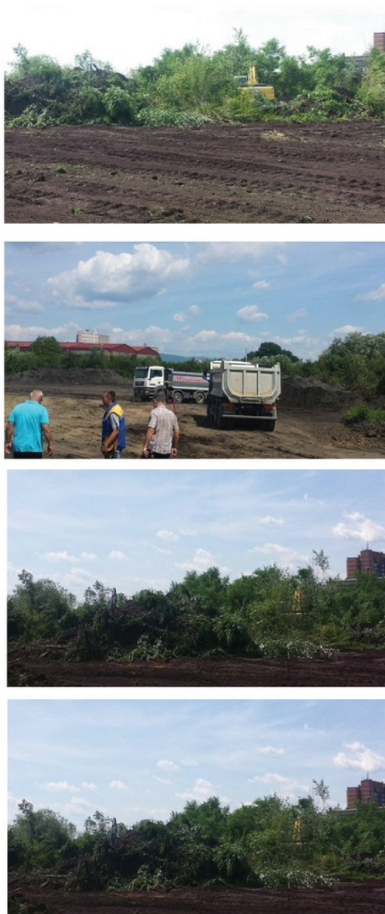
Slika 24 – Početak radova, jul 2015.
