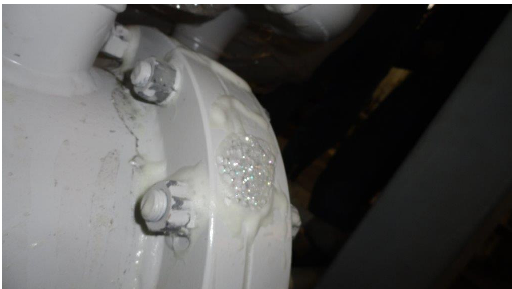
Slika 31: Curenje fluida na mestu zaptivanja
