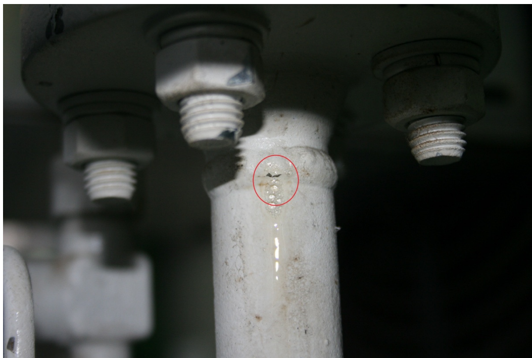
Slika 35: Curenje fluida na mestu zavarivanja
