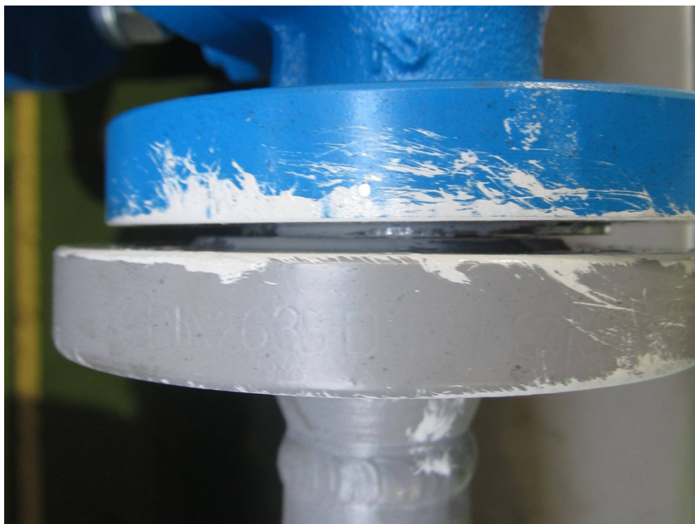
Slika 32: Dva dela opreme se ne mogu povezati zbog krivog ocvljenja
