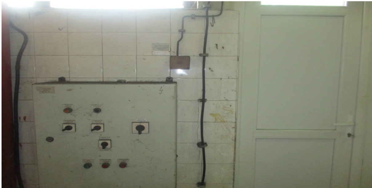
Слика 7: Разводни ормар са главним прекидачом
