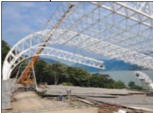
Slika 70. Postavljanje zaštitne konstrukcije sa krovnim pokrivačem na lokalitetu
