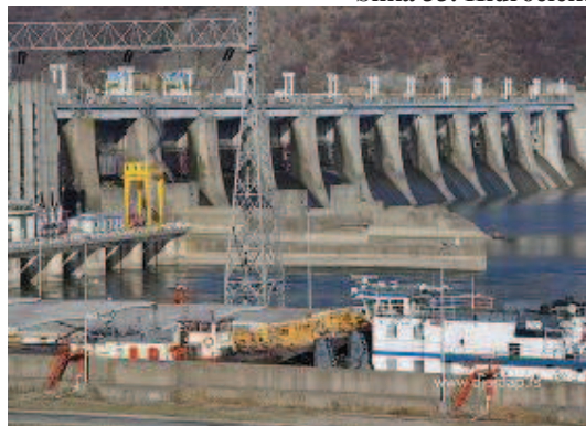
Slika 33. Hidroelektana „Đerdap I“
