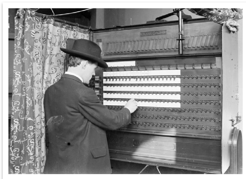
Слика 6. Машина за гласање која користи полугу за одабир кандидата 7 .
