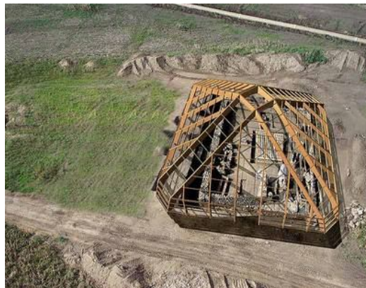
Slika br.26. Krovna konstrukcija
