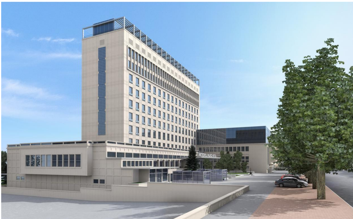
Slika br. 9: Izgled hotela Metropol Palace nakon rekonstrukcije
