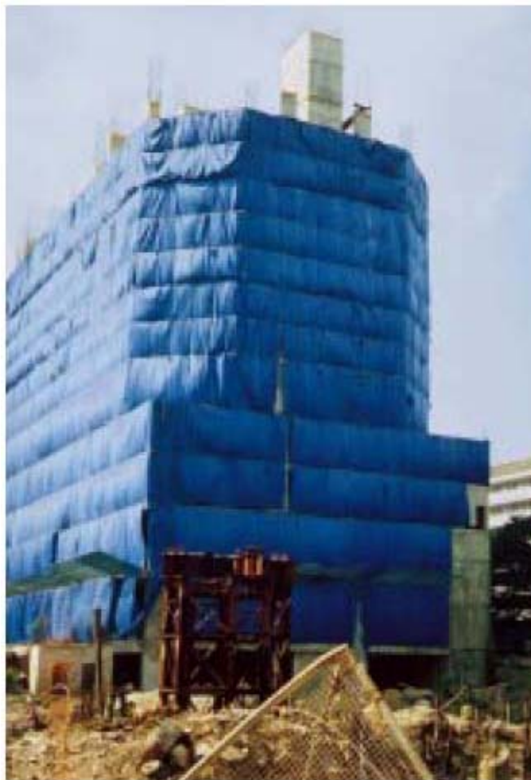
Слика 5. Заштитна мрежа око грађевинског објекта 17
