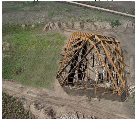
Слика 38. Костур заштитне конструкције
