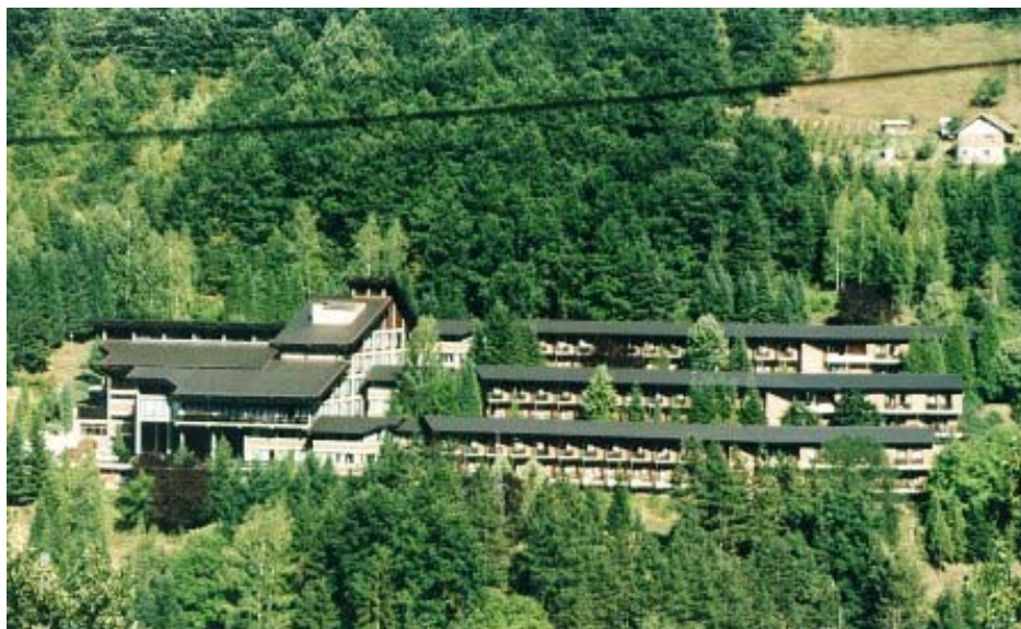
Slika br. 72: Hotel Specijalna bolnica za rehabilitaciju Ivanjica.
