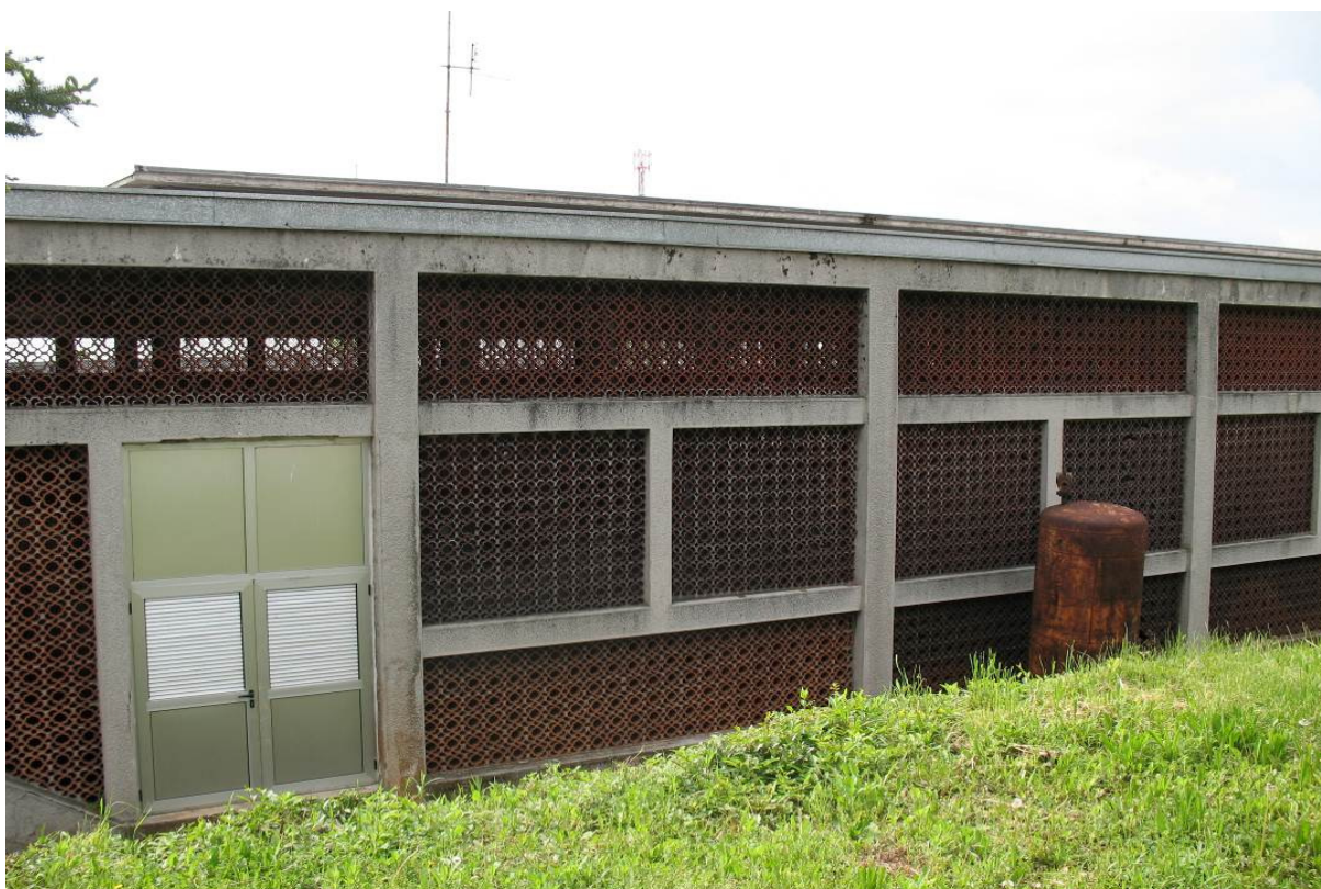
Слика 3. Спољни изглед аераторске сале
