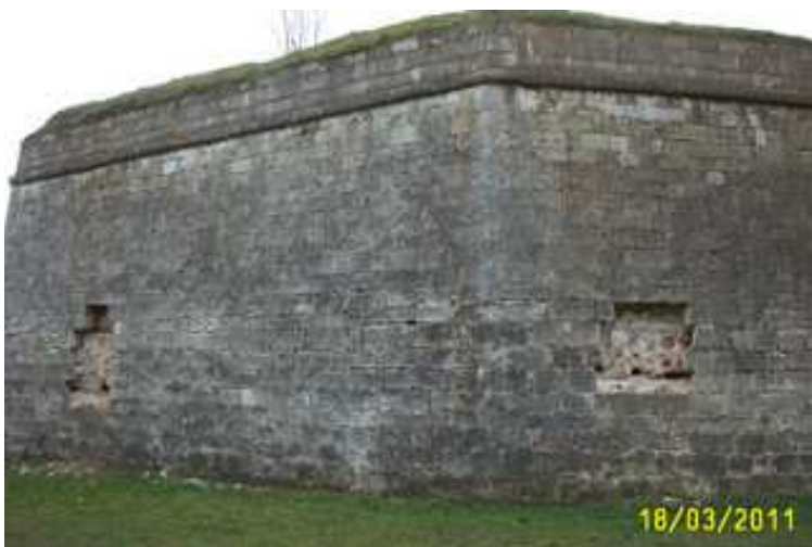
Otpadanje kamenih blokova i rupe u bedemima u tvrđavskom rovu
