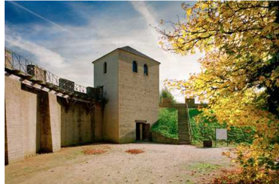
Pogled na rekonstruisani zid pored amfiteatra.
