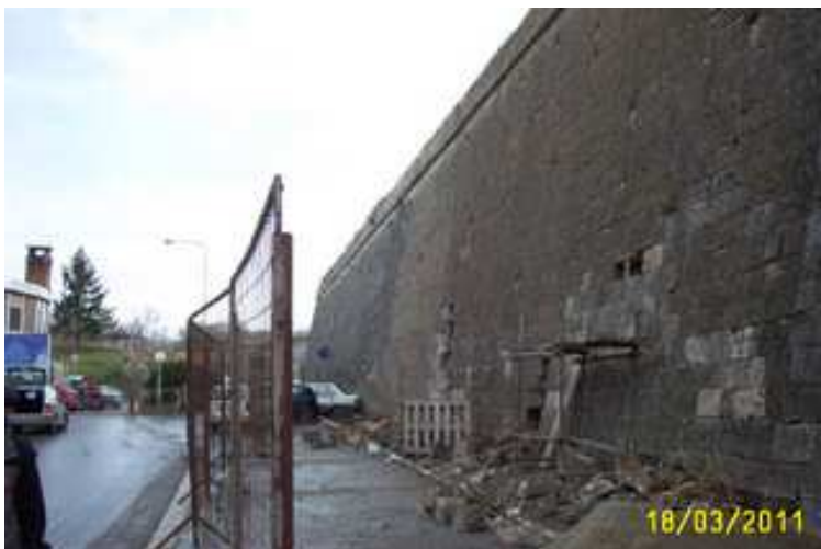
Malterisanje i "popravke" bedema kod glavne autobuske stanice
