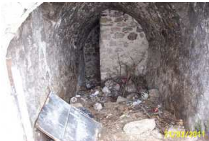
Zazidana poterna vrata kod Beograd kapije
