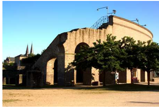
Rekonstruisani amfiteatar – nekad poprište surovih spektakala, danas kulturna destinacija.
