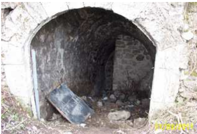
Zazidana poterna vrata kod Beograd kapije
