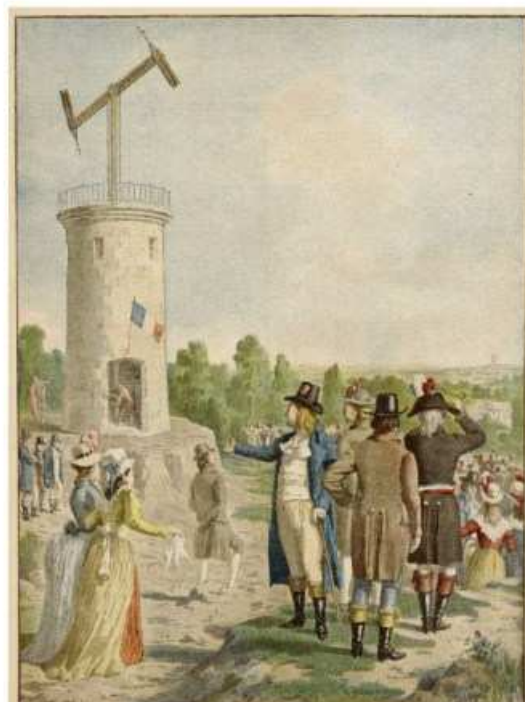
2.1.1. Optički telegraf Kloda Šapea iz 1792. godine u vidu niza tornjeva omogućio je brzu komunikaciju između Pariza i Lila
