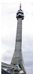
Slika 3: Toranj na Avali 27
