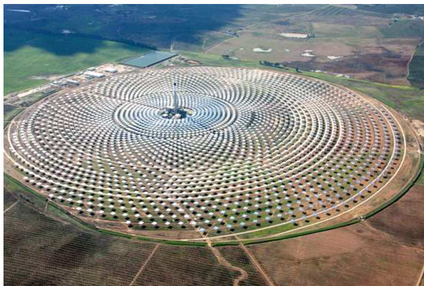
Slika 17 - Španija – elektrana koja radi danju i noću
