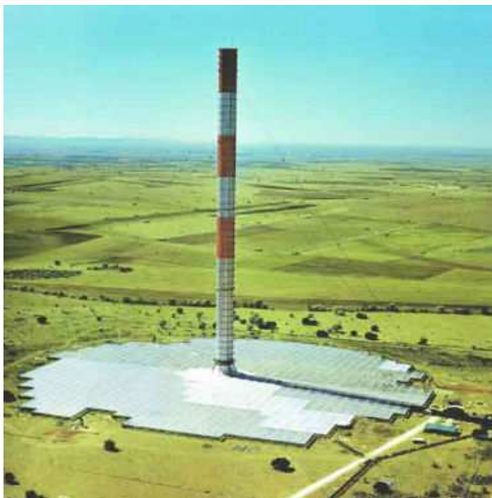
Slika 12 - Uzgonska solarna elektrana
