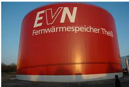
Slika 20 - Toranj za akumulaciju toplote, Theiss u Austriji sa kapacitetom od 2GW
