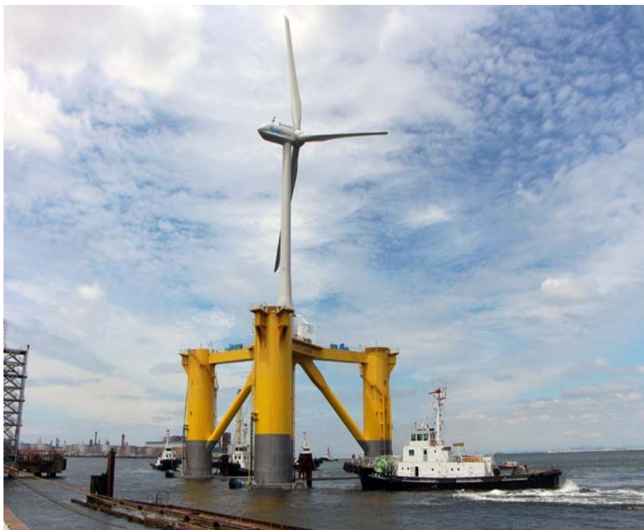
Slika broj 11: Vetrogenerator se odvlači na pučinu
