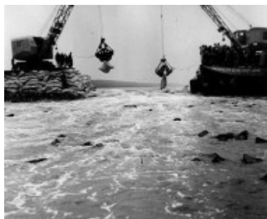
Slika 10 – postavljanje vreća sa peskom
