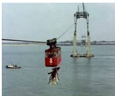
Slika 11 – prenos blokova preko 2,5 t težine
