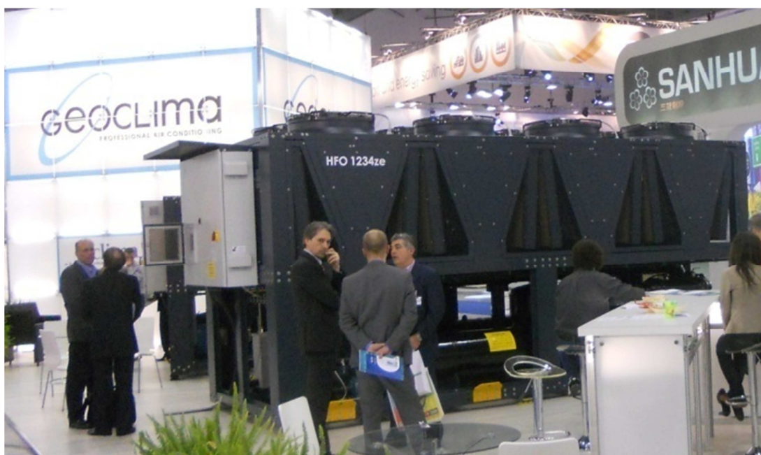
Slika 55. Čiler sa freonom HFO1234ze izložen na sajmu „MostraConvegno“ u Milanu (mart 2012. godine)
