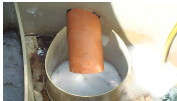
Сн. 1. Вход на отпадъчната вода към аеробната част
